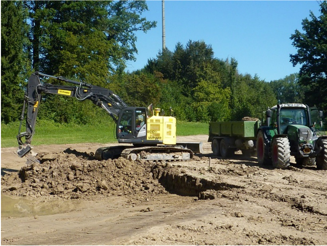
Der Aushub beginnt.
