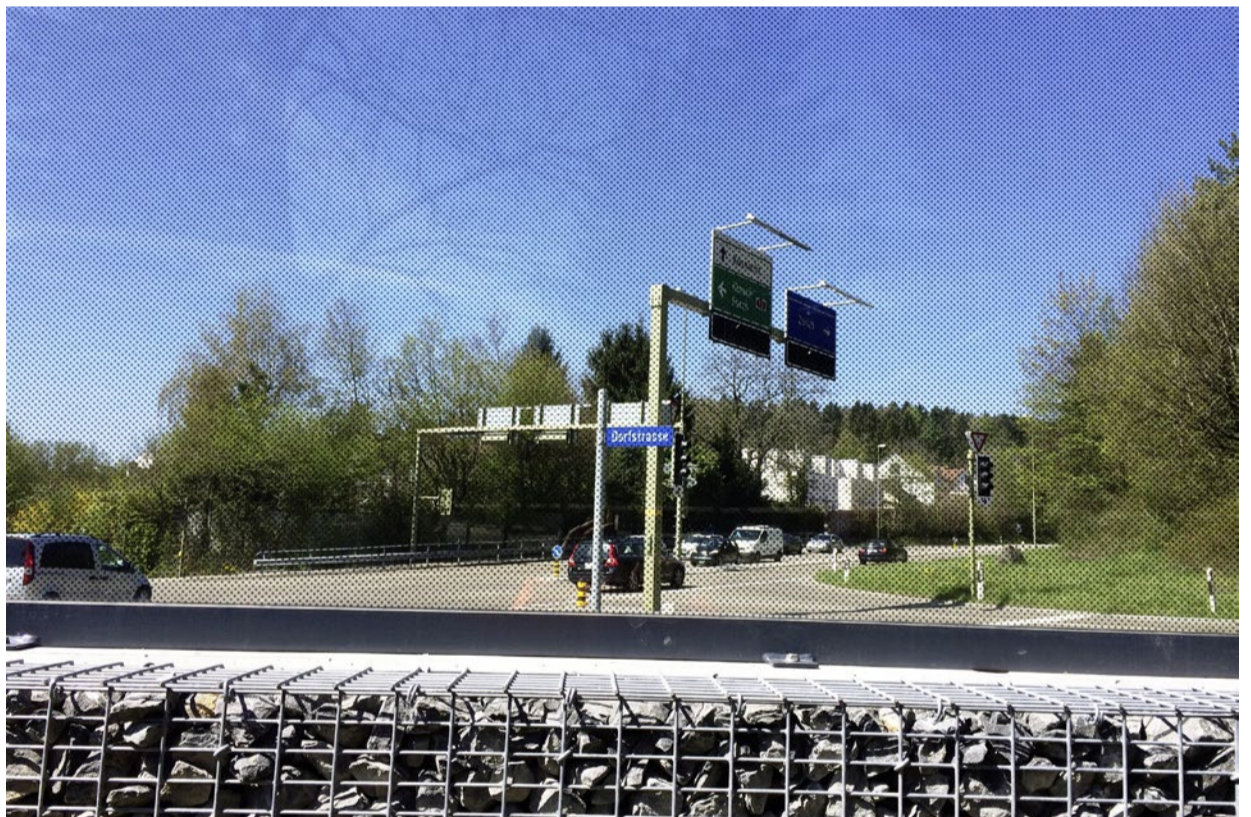
Lärmschutzwand in Zumikon mit Punktdurchmessern von drei Millimetern.
