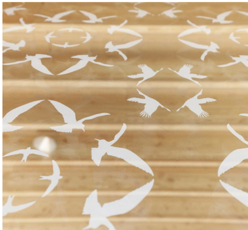
Ein flächendeckend aufgetragenes Dekor auf den Scheiben wie beim Besuchszentrum der Vogelwarte in Sempach schützt die Vögel vor Kollisionen.
