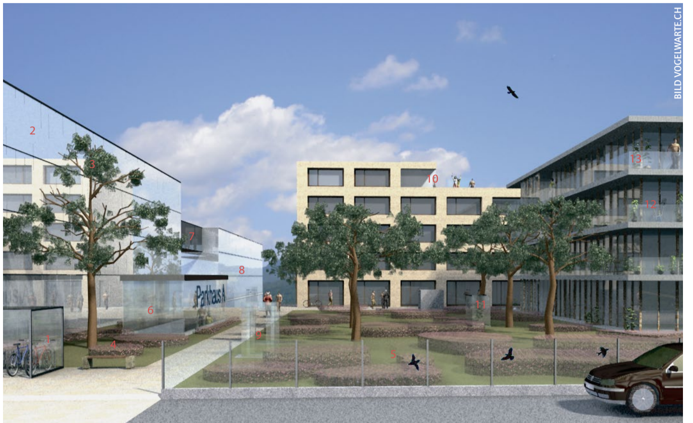
Übersicht der Gefahrenstellen in einer zeitgemässen Überbauung: 1 Fahrradunterstand in transparentem Material, 2 + 8 spiegelnde Fassaden, 3 Bäume vor spiegelnden Fassaden, 4 Grünflächen vor spiegelnden Fassaden, 5 transparente Lärmschutzwand, 6 verglaster Tiefgaragenaufgang, 7 transparente Fussgängerbrücke, 9 spiegelnde oder transparente Gartenskulpturen, 10 transparenter Eckbereich, 11 Wintergarten, 12 Balkongeländer aus Glas, 13 Pflanzen hinter transparenten Flächen.
