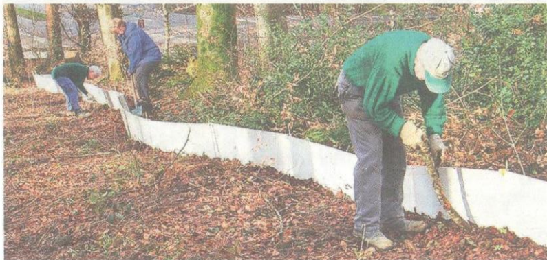
Der Amphibienzaun wurde an der Aettenschwilerstrasse aufgestellt.
